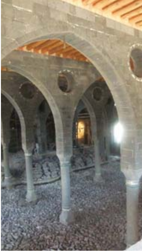
Döşemede blokaj serilmesi, güney yüzünde tamamlama ve alçı bezemelerde konservasyon çalışmaları
