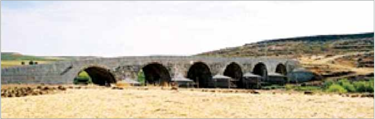
Karaköprü restorasyon sonrası
