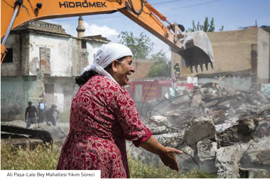
Ali Paşa-Lale Bey Mahallesi Yıkım Süreci
