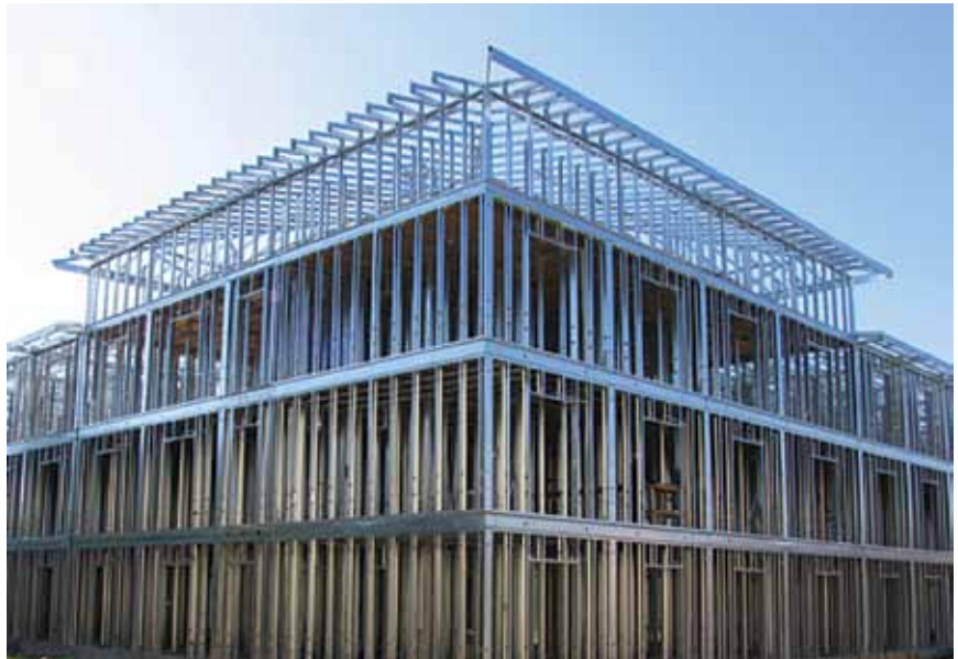
Şekil 1: Üç katlı hafif çelik bir sosyal bina taşıyıcı sistemi [8]
