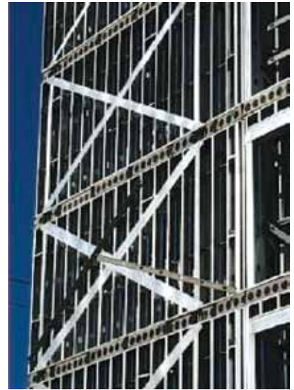
Şekil 7: Çelik çaprazlı duvar ve prefabrik döşeme paneli [7]
