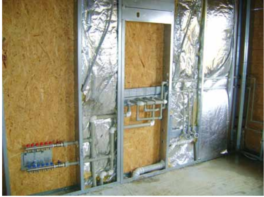
Şekil 2: Hafif çelik yapılar da mekanik tesisat uygulaması.
