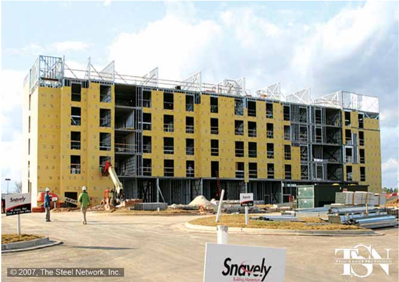
Şekil 5: 6 katlı hafif çelik yapı örneği [7]
