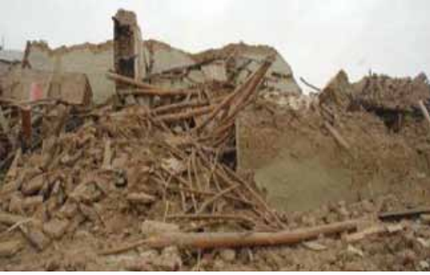
Şekil 5: Elazığ Okçular köyünde toptan göçmüş kerpiç yapılarla örnek
