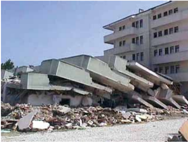
Şekil 4: Marmara Depreminde Malzeme ve Taşıyıcı Sistem Hatalarına Bağlı Yıkılmalar
