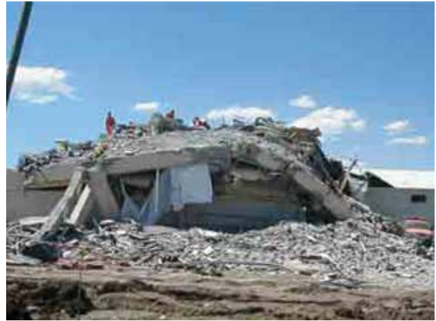
Şekil 4: Marmara Depreminde Malzeme ve Taşıyıcı Sistem Hatalarına Bağlı Yıkılmalar
