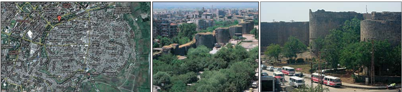
Fotoğraf 5. Diyarbakır Surları Genel Görünümü
