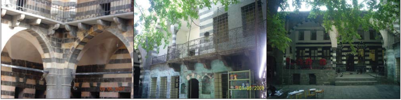
Fotoğraf 1. Diyarbakır Evlerinde Bazaltın Kullanımı
