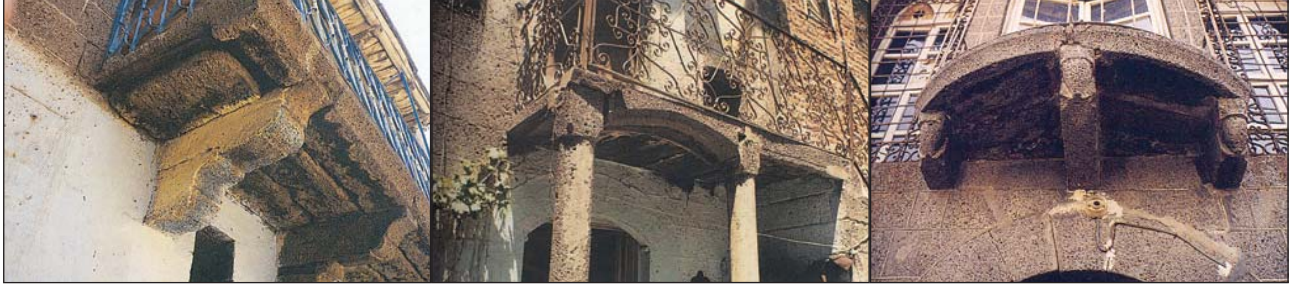
Fotoğraf 9. Bazaltın Merdiven Gezemeklerinde Kullanımı
