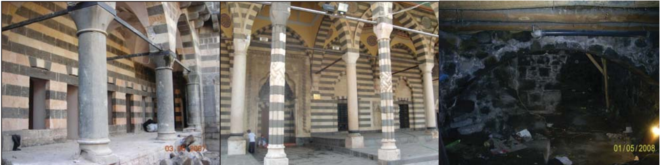
Fotoğraf 8. Bazaltın Nokta Taşıyıcılarda ve Kemerlerde Kullanımı
