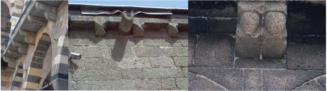
Fotoğraf 10. Bazaltın Silme (Ayıbaşı) Kullanımı
