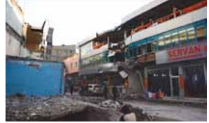
Van Merkezde Yıkılarak Devrilen Otel Binasından Hasar Gören İş Merkezi
