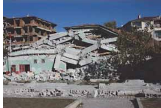
Erciş'te Yıkılan Yurt Binası
