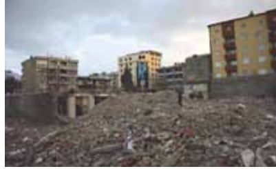
Van Merkezde Yıkılan İş Merkezi
