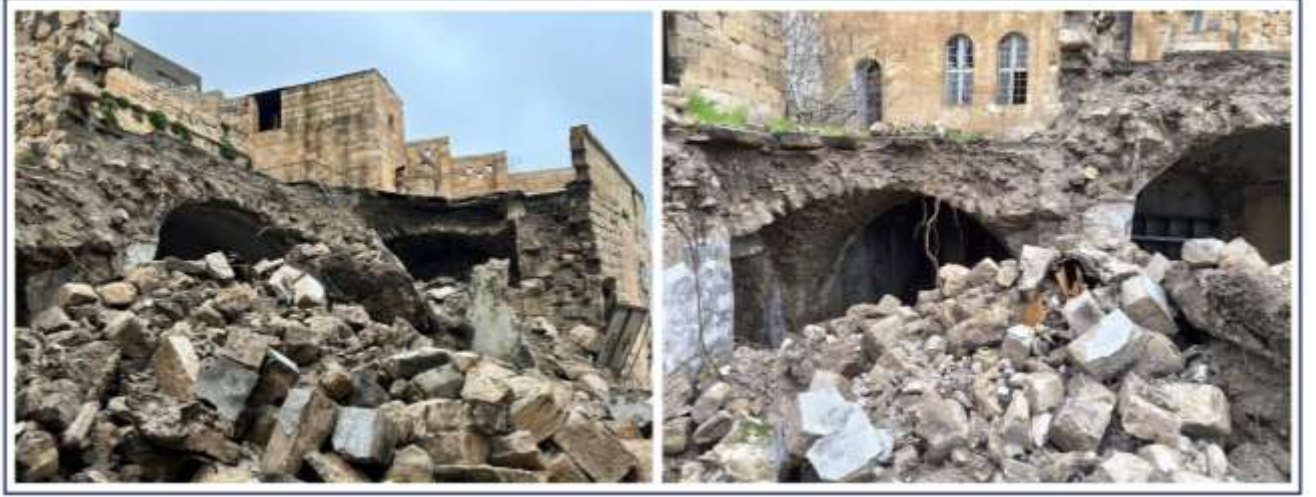
Şekil 6. Artuklu Şar Mahallesi 70 Ada 4-5 Parsel, Nisan 2026
