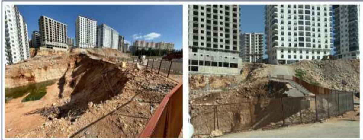
Şekil 2. Artuklu Nur Mahallesi Mardin Eğitim Araştırma Mevkii Çöken Yol Fotoğrafları, Nisan 2026
